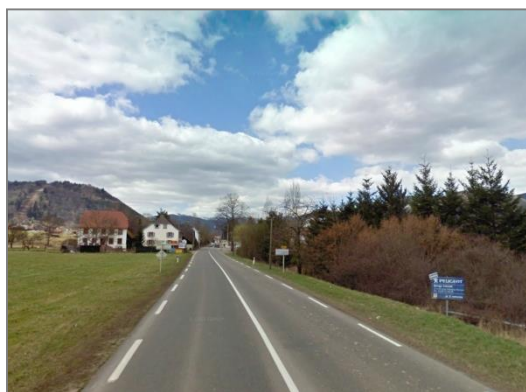
Entrée depuis Wihr-au-Val, via la RD 417
