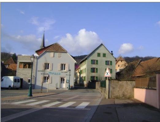
La hauteur des constructions est parfois importante (rue de la Gare)
