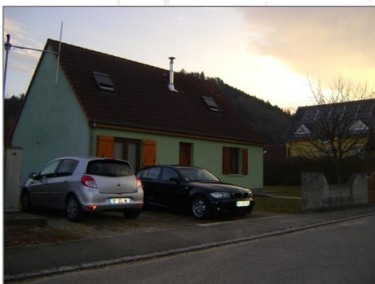
Quelques places de stationnement privatif sont accessibles directement depuis la voie publique (rue de la Peupleraie)
