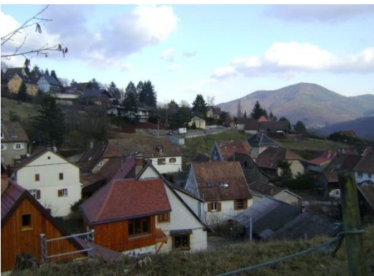
Vue permettant des perspectives sur les espaces bâtis
